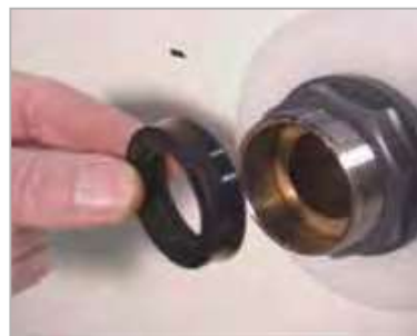
Plaats waterkering aan de putzijde met open zijde naar het bad.
