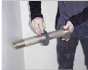
Pakking aanbrengen.
