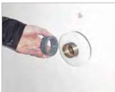
Plaatsen contramoer (handvast).
