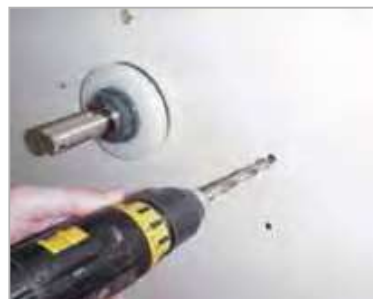
Gat boren \varnothing 11 . Minimaal 80 mm diep.
