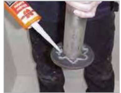
Kit op pakking aanbrengen.
