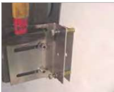
Plaats pluggen voor boorgaten en met een hamer inslaan tot boutkop tegen de beugel komt.
