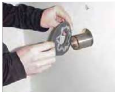
Pakking met kit plaatsen in motorput.
