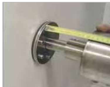
Lengte afstandsbus bepalen en op lengte maken.
